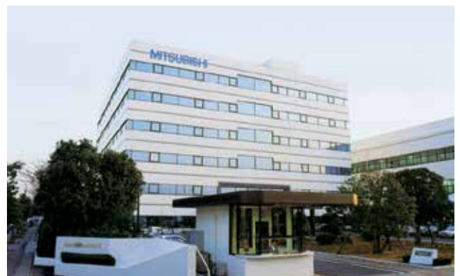
L'usine de SHIZUOKA au Japon
